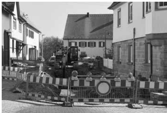
Die alten Kanäle und Wasserleitungen werden im Zuge der Maßnahme ausgetauscht.
