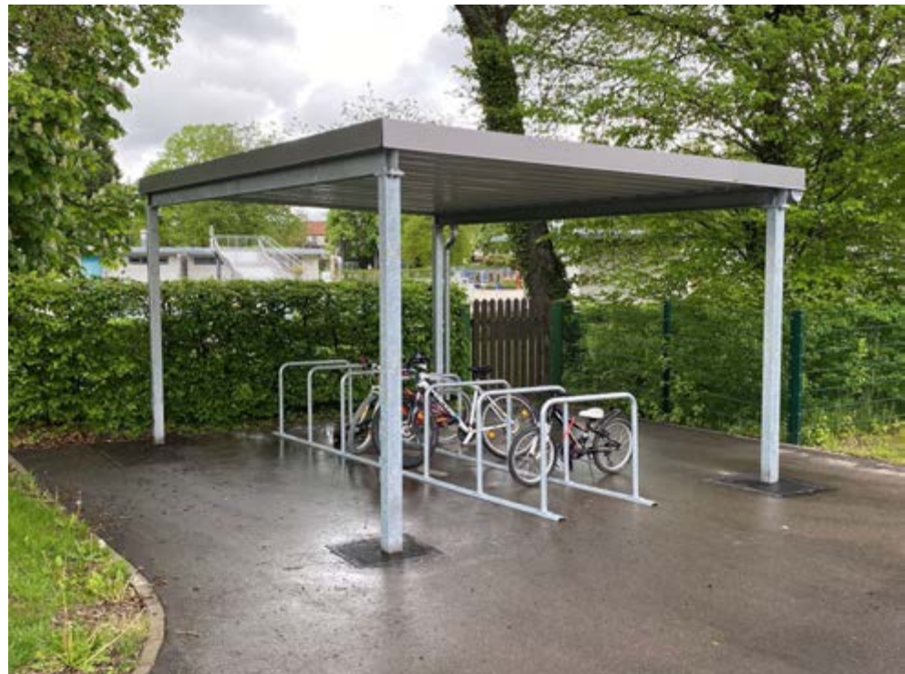
Einer der überdachten Fahrradabstellplätze am Geislinger Schulcampus
