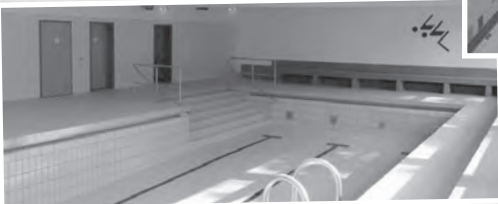
Das Lehrschwimmbecken im Untergeschoss bleibt erfreulicherweise erhalten.
