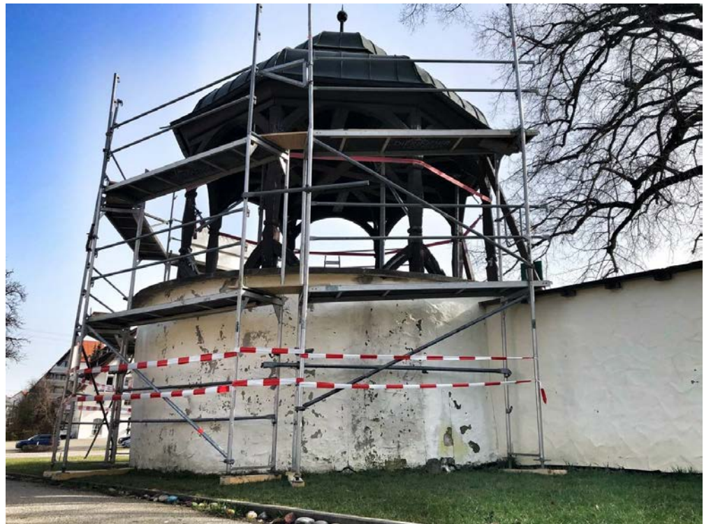
Der achteckige Holzpavillon im Schlossgarten wird saniert.
