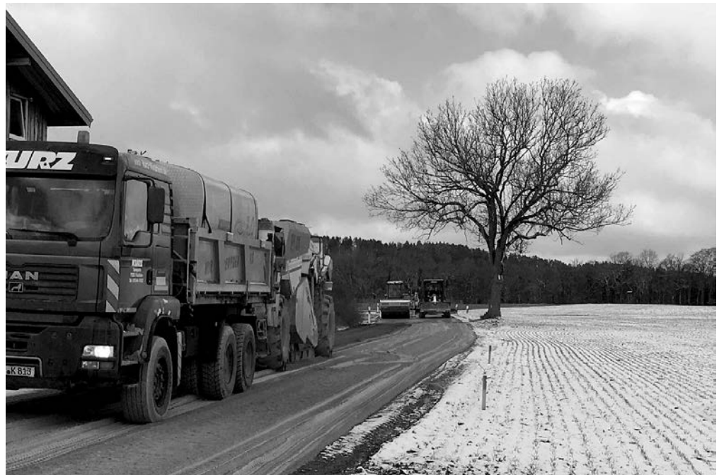
Die Spezialfräse beim Einfräsen des Bindemittels.
