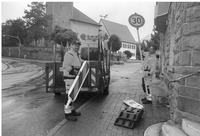
Mitarbeiter der Straßenmeisterei Balingen bauen die Verkehrszeichen „Tempo 30“ ab.
