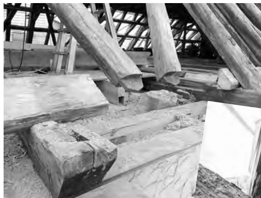
Morsche Dachteile sind entfernt
