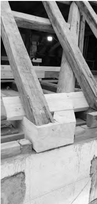
Hier sind sie fertig ausgetauscht.
