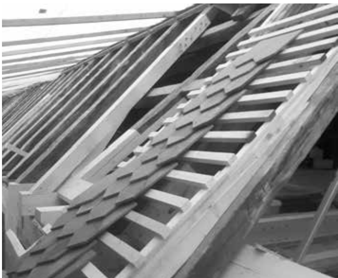
Hier wurde ein Probestück erstellt: Unterbau mit Dachlattung und Dachpfannen, wie liegen sie sicher, gut und auch historisch einwandfrei?
