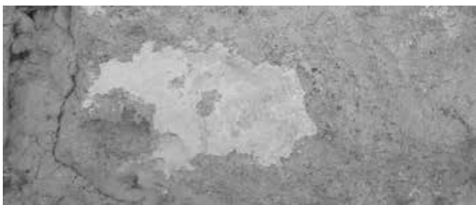
Der helle „Fleck“ auf diesem Bild ist noch der allererste Original „Putz“, der direkt nach dem Bau des Klosters auf die rohen Steine aufgetragen wurde, eine Art Kalkschlämme, damit das Kloster „nach was aussah“, auch bevor man sich das teure Verputzen leisten konnte. Diese Schlämme wurde noch an verschiedenen Stellen auf der Rückwand des Klosters gefunden.
