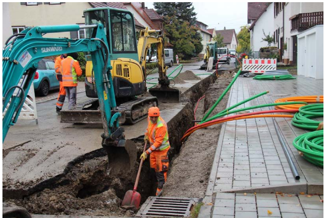
Die Verlegung der Leerrohre in der Lindenstraße.
