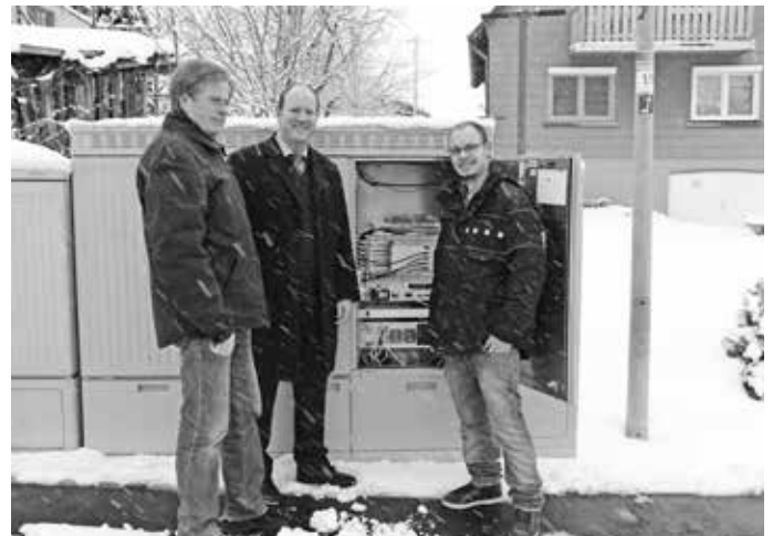
(v. li.) Freuen sich über die Verbesserung der Breitband-Infrastruktur in Binsdorf: Ortsvorsteher Dr. Hans-Jürgen Weger, Bürgermeister Oliver Schmid sowie Ausbauleiter René Fischer (Telekom Deutschland GmbH)
