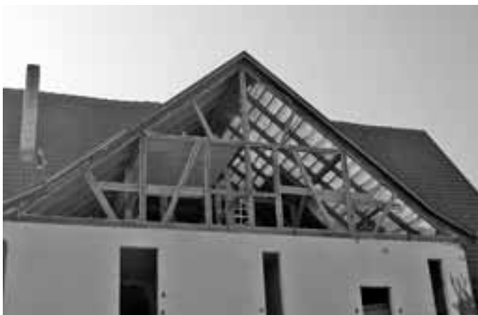
Die ersten Arbeiten an der „Harmonie“ haben planmäßig im März begonnen.
