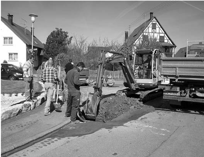
Grabungsarbeiten am Sonntag, 1.4.2012, gegen 11 Uhr im Bereich der Hohenbergstraße in Binsdorf zur Behebung des Defekts.
