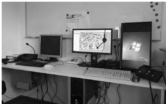
Funkzentrale im neuen DRK Funktionsgebäude
