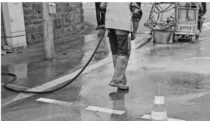
Ein Mitarbeiter der beauftragten Firma fräste am Fußgängerüberweg an der Vorstadtstraße die Bordsteine beiderseits schräg ab, um das Überqueren der Straße insbesondere für Personen mit Gehhilfen zu erleichtern.
