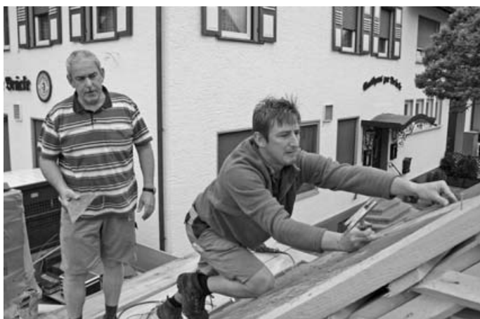
von links: Jürgen Bühler und Frank Ott vom Team des städtischen Bauhofes bei den Dachdeckerarbeiten
