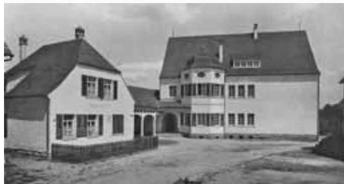
Schulhaus mit Lehrerwohnung in Binsdorf
