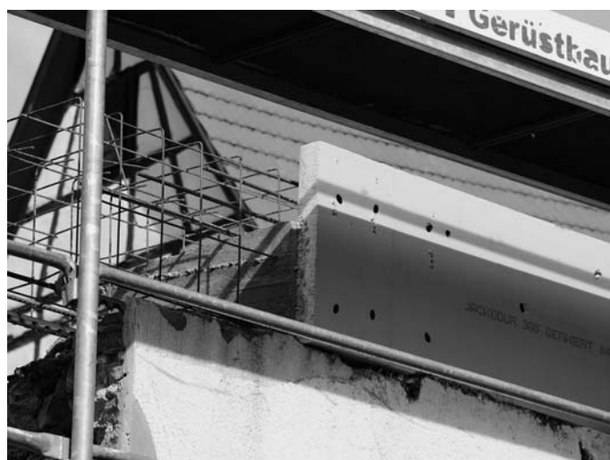
Blick auf den mit Stahl bewehrten Betonringgurt, an dem bereits eine Wärmedämmschicht angebracht wurde.
