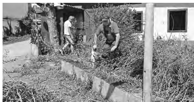
Die Hecken und der alte Zaun am Gebäude wurden noch vor Baubeginn entfernt.
