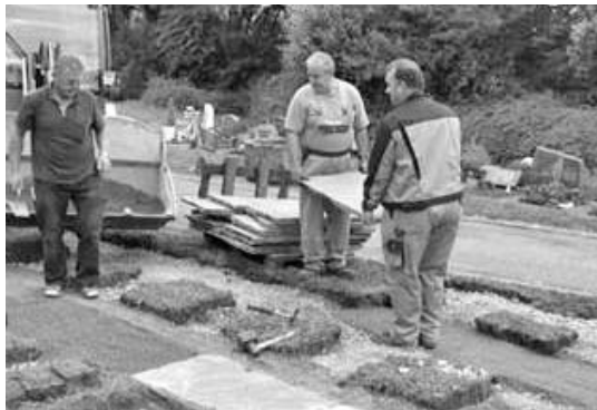
Einbau der Platten
