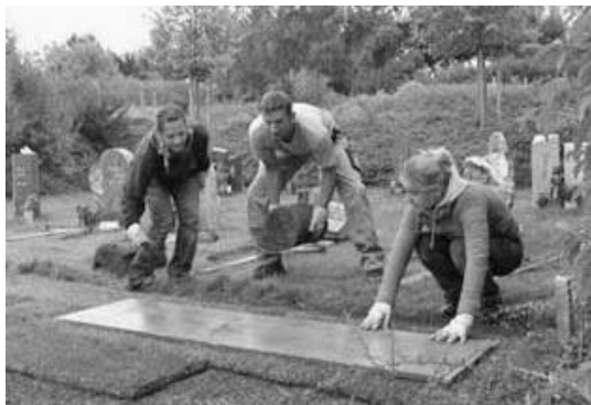
Verlegen des Rollrasens
