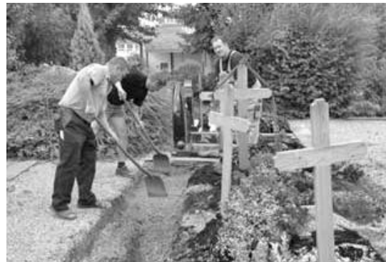
Einbringen der Fundamente
