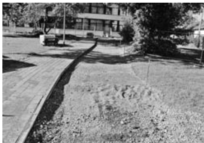
An dieser Stelle werden Rasengittersteine verlegt werden, als Zufahrt für Pellets-Lieferanten
