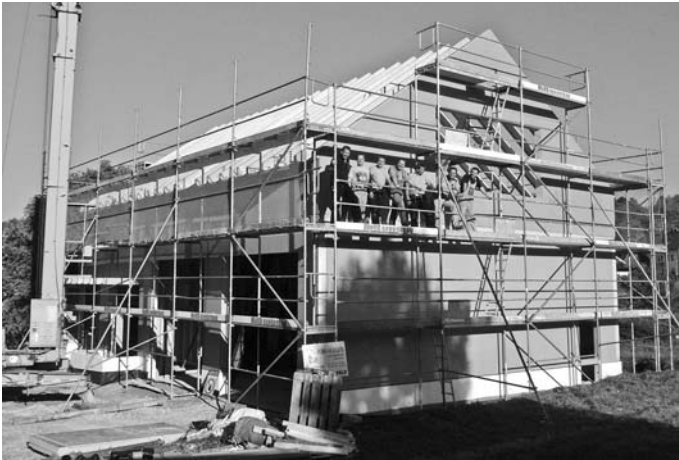
Das neue Feuerwehrhaus konnte am vergangenen Wochenende aufgerichtet werden.
