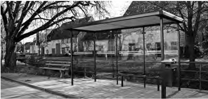
Das neue Buswartehäuschen in Geislingen, Bachstraße
