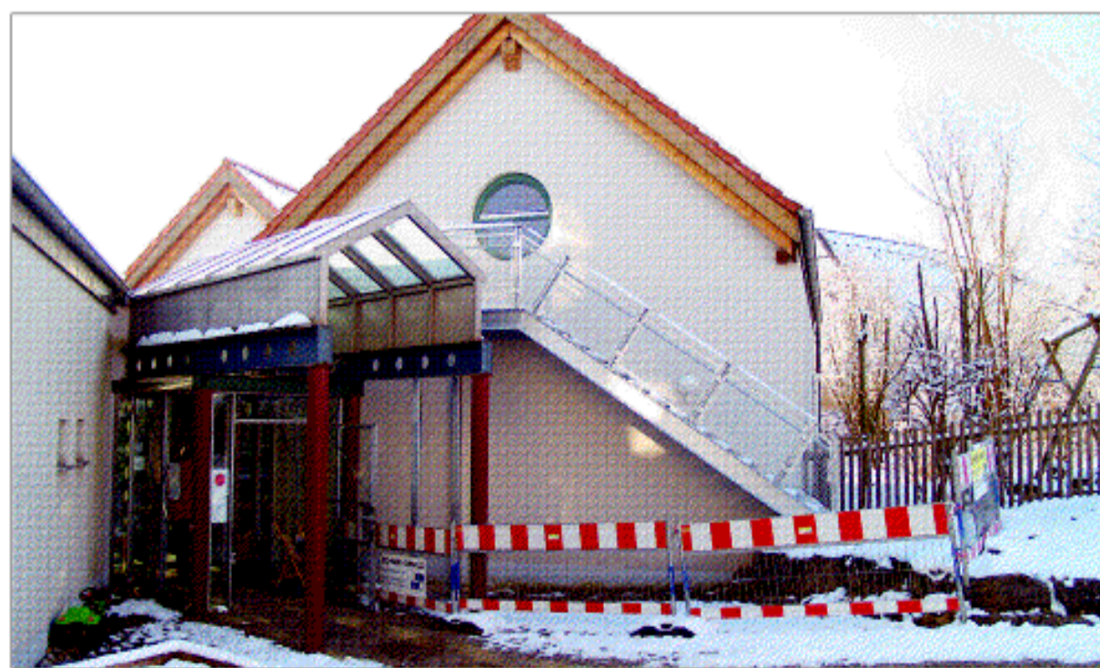
Noch kann man über die neue Außentreppe beim Dormettinger Kindergarten im Notfall nicht flüchten, da die Paniktür noch fehlt. Die hintere Treppe ist bereits in Bestellung und soll Anfang April montiert werden. Ein weiterer Fortschritt: die Wasserrinne zwischen Glasgang und Dach ist nun saniert. Foto: Saskia Scherer
