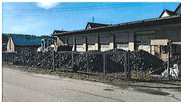
Abb. 15: Ostfassade der Fahrzeughalle
