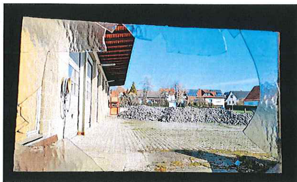
Abb. 6: Blick aus dem Gebäude auf die Hoffläche
