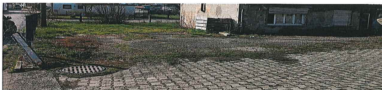
Abb. 9: Hoffläche mit Asphaltbelag oder mit Beton-Verbundpflaster
