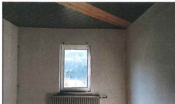
Abb. 17: Dienstgebäude mit Raum im Erdgeschoss
