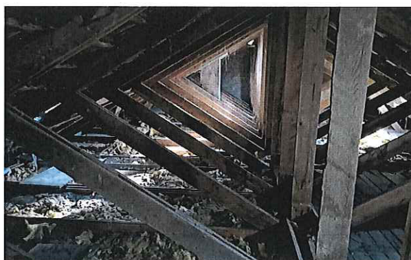
Abb. 21: Dachstuhl im Firstbereich
