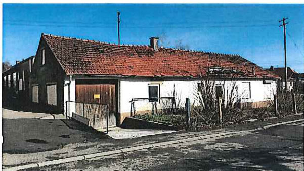
Abb. 14: Südfassade des Dienstgebäudes
