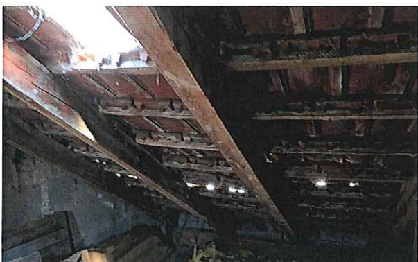
Abb. 20: Dachstuhl mit Blick zur Traufseite
