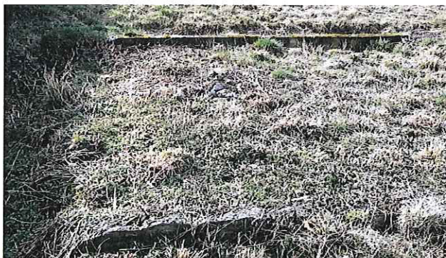
Abb. 10: Streifenfundamente des ehemaligen Gewächshauses
