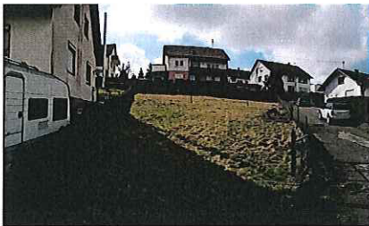
Abb. 6: Blick in das Plangebiet aus nördlicher Richtung
